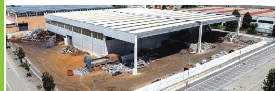
FERMET HEADQUARTER | SEDE VIA SAN MARTINO DELLA BATTAGLIA 14
