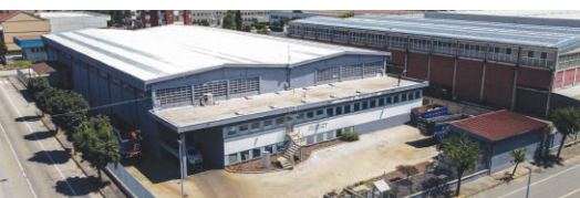
FERMET HEADQUARTER VIA GOITO | SEDE VIA GOITO 5
